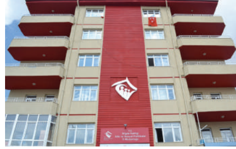
Resim 3.4.4: Sosyal Hizmet Merkezi Müdürlüğü Hizmet Binası
