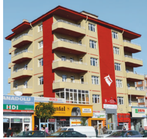
Resim 3.4.3: ASPİM Hizmet Binası
