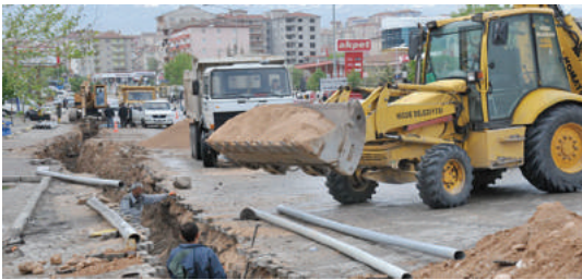
Resim 3.8.2: Niğde İli Kanalizasyon Çalışmalarından Bir Görüntü
