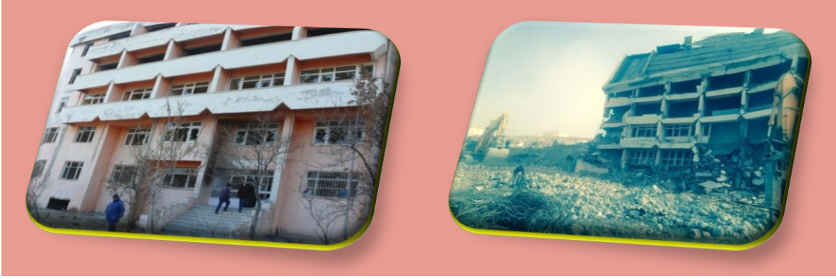
Riskli Yapı (Eski Besyo Binası)
